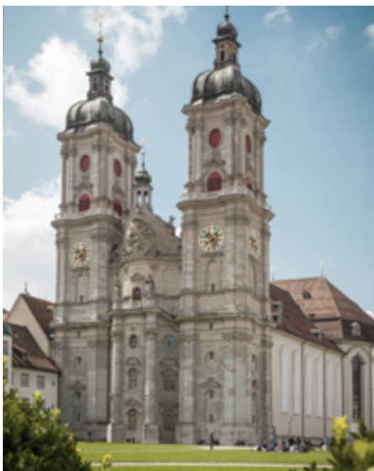
La chiesa collegiata di San Gallo che funge da cattedrale per la diocesi di San Gallo.
