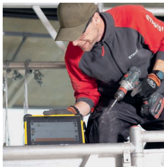
10 | Effizienz auf Baustellen dank BIM Wie die Digitalisierung Zeit spart und die Qualität erhöht
